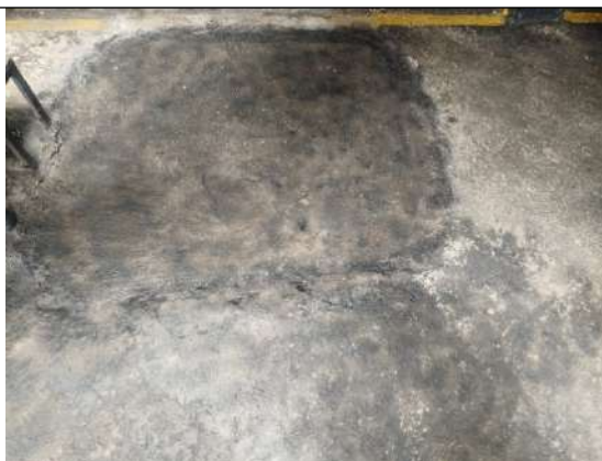
Foto No. 17. Placa de concreto que cubre la boca del pozo
