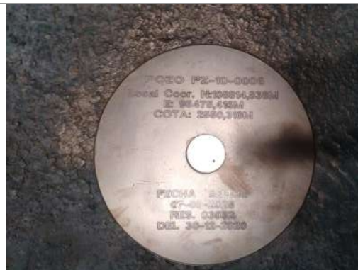
Foto No. 19. Instalación de placa de identificación
