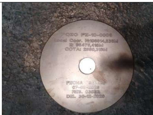
Foto No. 20. Instalación de placa de identificación
