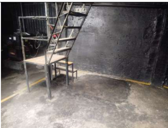
Foto No. 16. Vista general del sellamiento realizado
