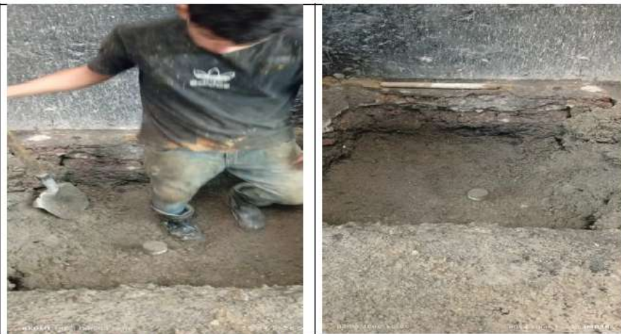
Cemento gris y bentonita mezclados en proporción 1:1
