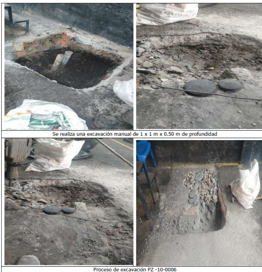
Imagen No. 6. Excavación
