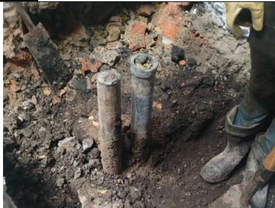
Foto No. 6. Despeje de la boca del pozo
