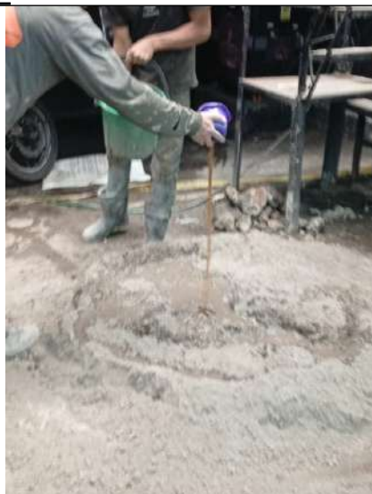
Foto No. 15. Rellenado del área alrededor del pozo
