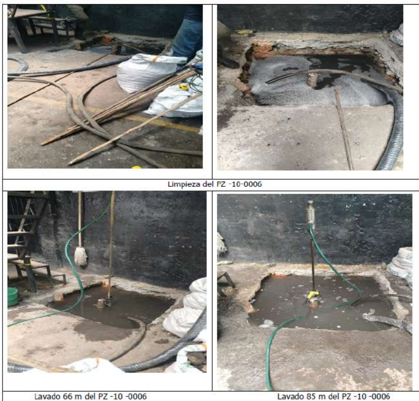
Imagen No. 7. Lavado del pozo Fuente. Radicado 2025ER114754 de 29/05/2025
