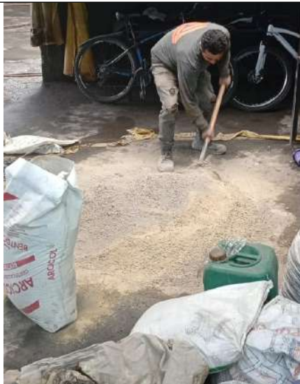
Foto No. 12. Preparación de material de llenado del pozo
