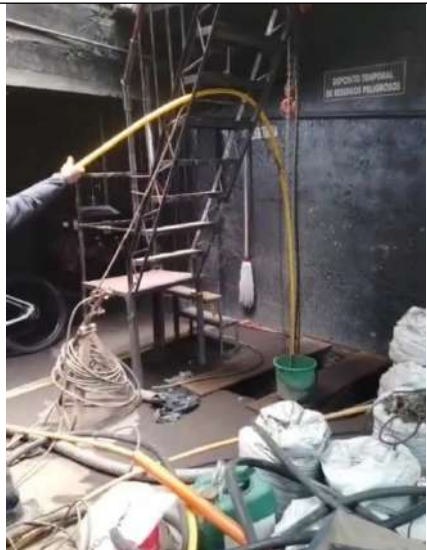
Foto No. 10. Retiro de tubería de inyección de aire
