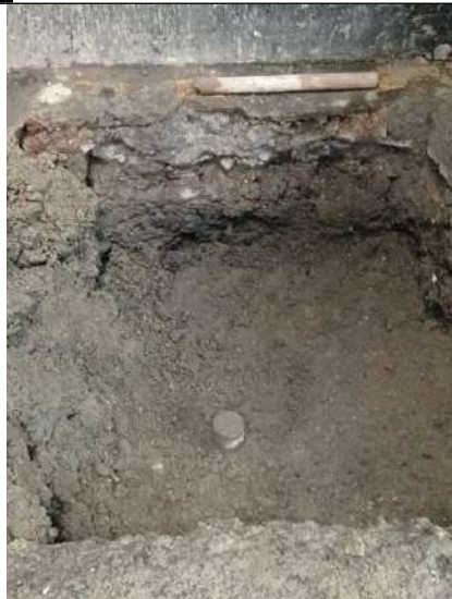
Foto No. 13. Culminación de llenado del pozo
