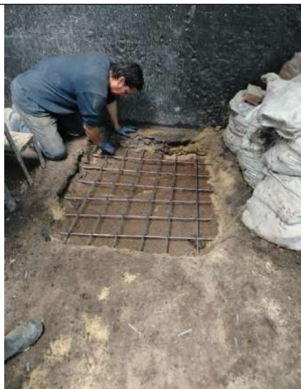
Foto No. 14. Refuerzo con malla de hierro de \frac{3}{8} "
