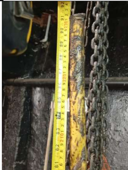
Foto No. 11. Total de 80m de tubería de inyección de aire
