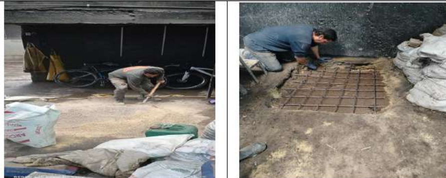
Llenado del espacio restante de la excavación con concreto, y refuerzo en la parte superior con malla metálica de 3/8.
