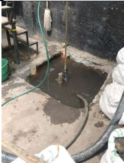
Foto No. 9. Cepillado al interior del pozo
