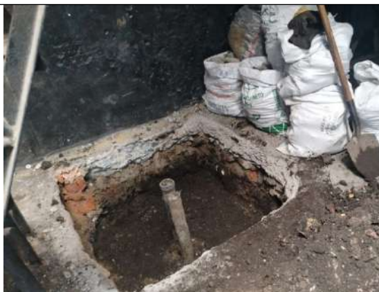
Foto No. 7. Finalización de excavación
