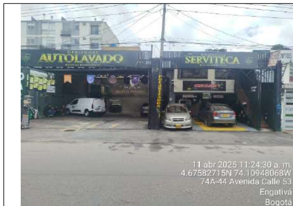
Foto No. 1. Vista general de entrada al predio
