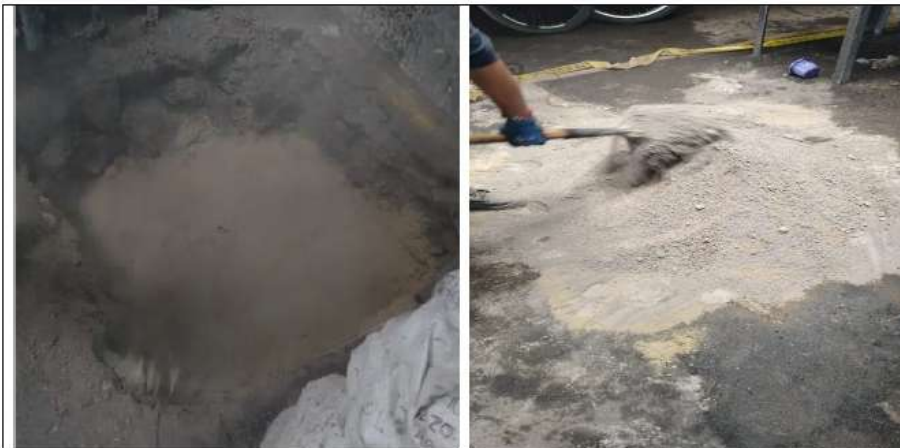
Aplicación de 15 cm de bentonita hidratada en capas de 5 cm.
